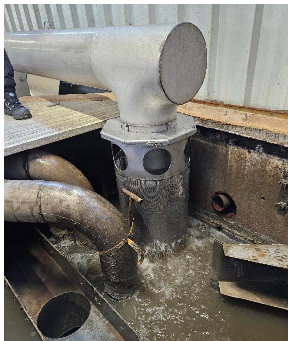
Bild 8 Utloppssil för silning av vatten som släpps i kanal.
